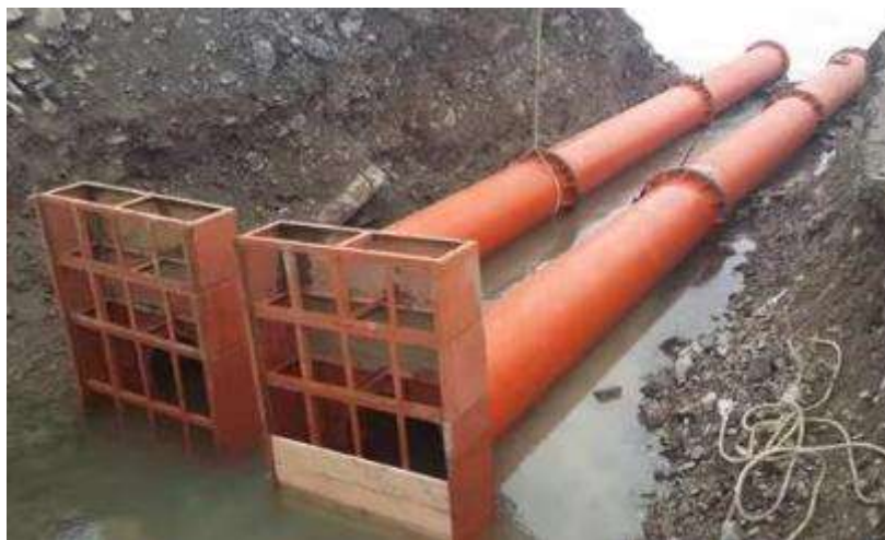
图 9.1-1 闸箱式结构
